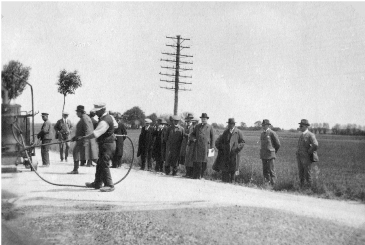
Fast stof i tidsskriftet var referater fra faglige møder. Amtsvejsinspektørernes årlige møde havde altid meget praktiske indslag. Værtsamtet arrangerede besøg på dets veje. Her ser man på tjæring med tjæringsmaskine i Vejle Amt i 1920.
