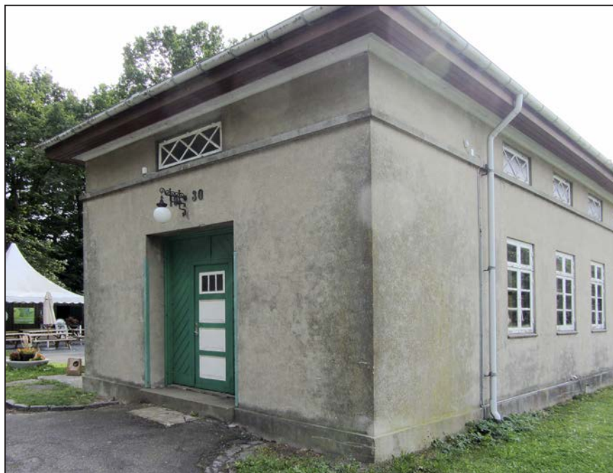
Københavns Kommune byggede i 1930 en pumpestation ved gården Kildedal. Bygningen ligger der endnu, men vand til hovedstadens beboere er for længst stoppet, da vandet var forurennet med gifte fra Cheminova. (Foto: Svend Jørgen Jensen).
