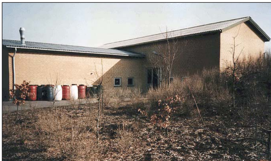
Amtsborgmester Per Kaalund indviede i 1986 denne større bygning til at rumme et rensningsanlæg. Endnu ved ingen, hvor mange år forgiftet vand fortsat skal op- pumpe og renses. (Region Hovedstaden).
