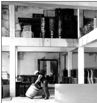
Bag hovedbygningen lå en fabriksbygning med gallerier fyldt med råvarer, halvfabrikata og færdigvarer. (Lyfaparken).
