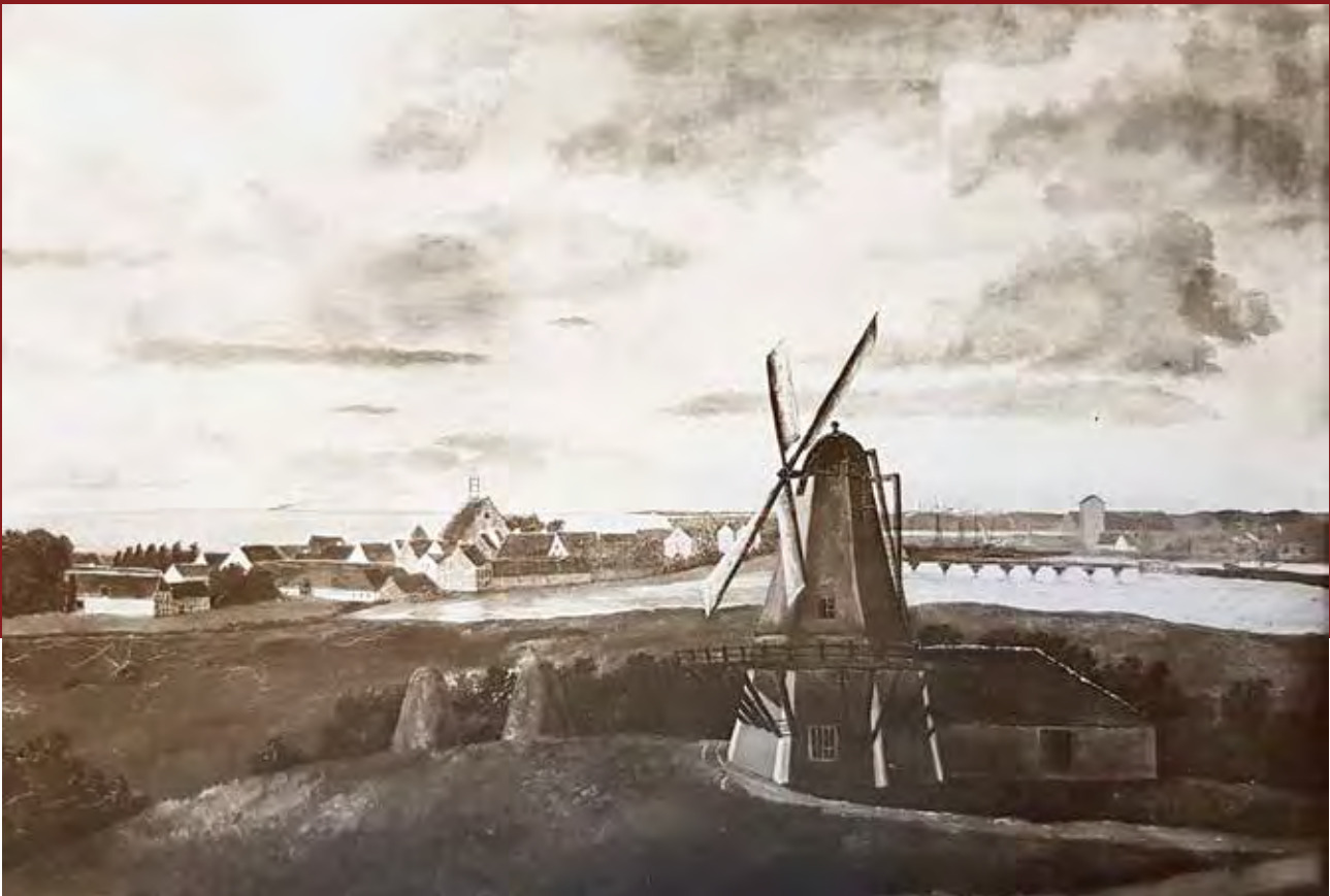
Maleriet fra omkring 1850 af Korsør set fra en møllebakke øst for noret viser den første bro til højre for møllen. Pælebroen ses foran Korsør Fæstning og med en opdæmning til højre ud mod Halskov (malet af major Darchov, Korsør Lokalkiv).
