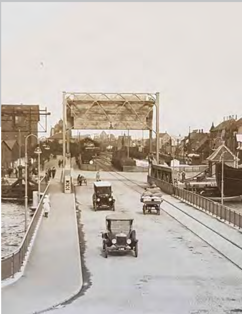
Bro nummer fire var karakteriseret af den store kontravægt på mere end 400 tons. I baggrunden ses den daværende Korsør jernbanestation (ca. 1928, Korsør Lokalarkiv).
