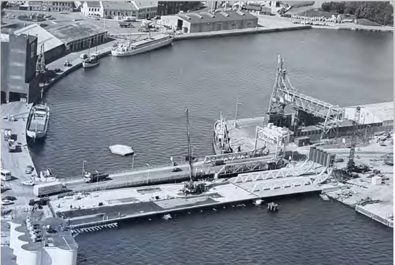
Igen blev en ny bro bygget øst for den tidligere. Fundamentet til pillen for bro nummer tre ("Carl Peter") viser den tidligere bros placering. Her er den femte bro under opførelse i 1984. Bemærk dens bredde ind mod det gamle Korsør for at kunne lede trafikken til højre. (Ivan Svendsen, Lokalthistoriske Arkiv for Korsør og Omegn).
