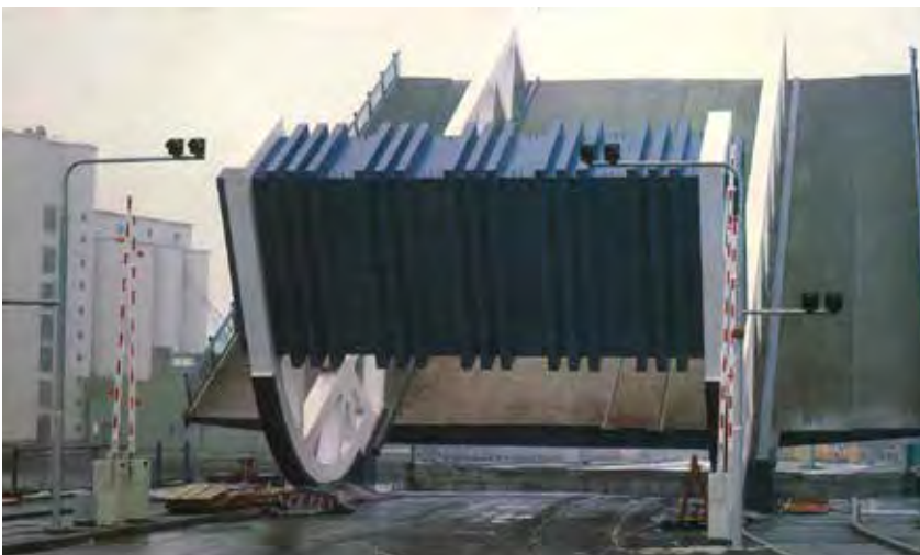
Kontravægtens 810 ton til at afbalancere broklappen er bygget af svære stålkodser. I øvrigt hjalp en arkitekt med design af kontravægten, så den blå-riflede vægt så mindre massiv ud end sin forgænger. Billedet viser også broens vuggesystem (Ivan Svendsen).
