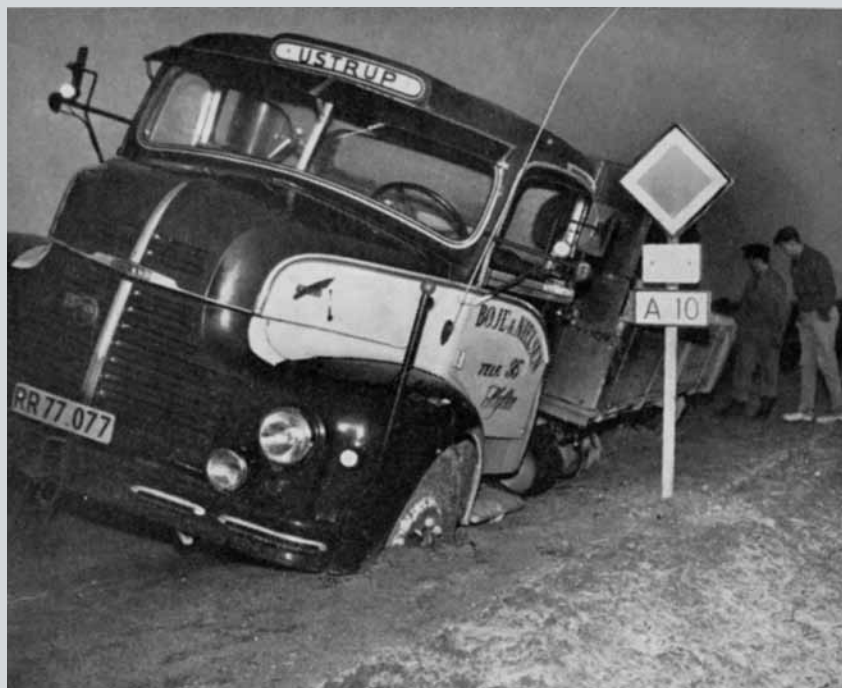
Fig. 14. Vejene kunne undertiden bryde sammen under de tunge køretøjers vægt. Det skete især ved vintertøbrud om foråret, som her ved Hovedvej 11 i 1963. I en årrække var der næsten hvert år perioder med forbud mod at køre med tunge køretøjer på nærmere angivne landeveje.
