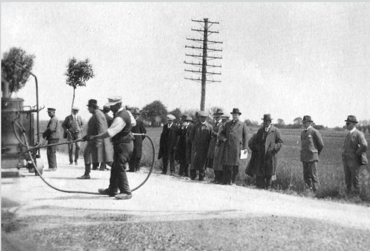
Fig. 9. Løsningen på problemet med de vejødelæggende hurtige bilhjul var ret simpel. En overfladebehandling kunne holde på sandet, som her hvor landets amtsvejsinspektører ser på automatisk tjærebehandling i 1920. Kort efter var en stor del af landets veje blevet behandlet, og restriktionerne kunne løses.
