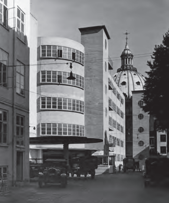
Figur 3. Landets første parkeringshus blev bygget i 1933 efter forbillede fra de mest moderne udenlandske bygninger. Det blev også kaldt Palægaragerne, da det blev opført i den tidligere have til Moltkes Palæ. Foto fra 1947.
