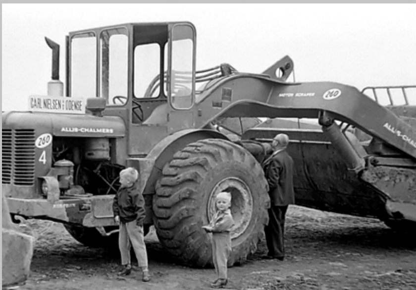
Omkring 1960 kom mange nye maskiner ind i vejbyggeriet. Her har Harald K. Hansen en familieudflugt i 1961 til et vejbyggeri med scraper.
