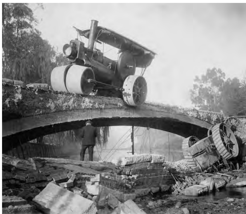
First King's bro i Bendigo, Australien, bestod ikke i 1901, da to damptrømler testede konstruktionen. Halvdelen af betonbroen faldt sammen. University of Melbourne Archives 1964.0012.00260.
