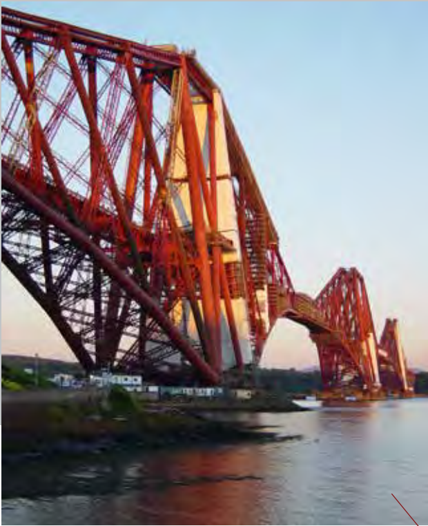
Gitterbro. Jernbanebroen Forth bro, Skotland, åbnede i 1890 og er stadig i brug. Euchiasmus, Wikipedia.
