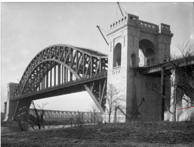
Buebro (overliggende). Hell Gate broen i New York fotograferet lige efter dens indvielse i 1916. The Detroit Publishing Co. collection at the Library of Congress.
