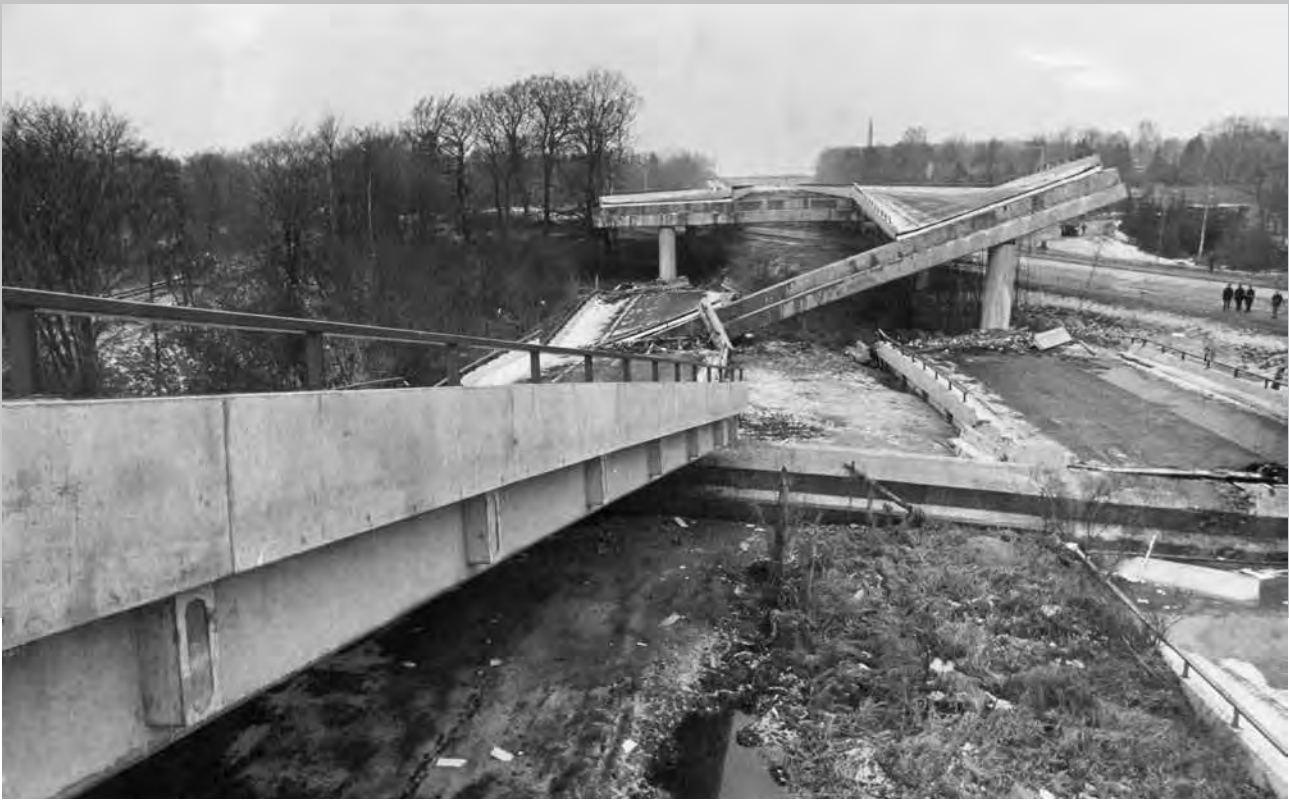
Den ødelagte Fiskebækbros i 1972. Broen havde stået færdig i et år, da tre fag pludselig kollapsede. Heldigvis var motorvejen på broen endnu ikke taget i brug. Foto: Karl Høver. Scanpix.
