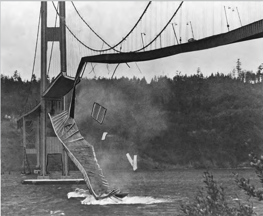
← Verdens mest kendte brostyrt er antagelig Tacoma Narrows bro, Washington. Under en storm i 1940 få måneder efter dens indvielse begyndte den at svinge faretruende, og til sidst faldt den sammen. Texas State University.
