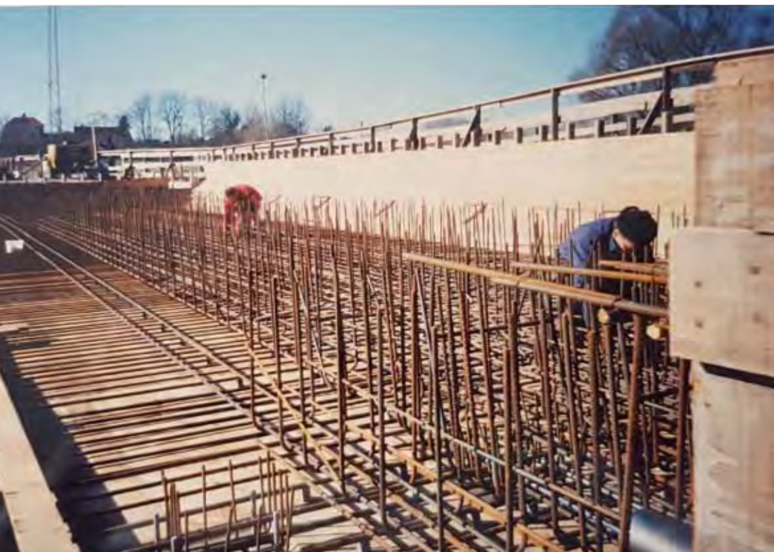
Takket været en kraftig armering kan den aktuelle Åsum Bro have et frit spænd over hele åløbet. Carl Bro, Danbro. Hjalmar Reitz. Foto: Åsum Sogn Lokalhistoriske Arkiv, .
