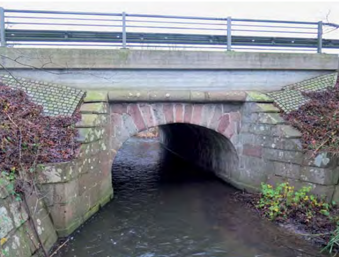
Den nye meget lige hovedlandevej, planlagt i slutningen af 1700-årene, blev hovedforbindelsen over Fyn og mindskede Åsum Bros betydning. Den solide bro af tilhuggede kampesten over Lindved Å krævede et minimum af vedligehold. Stadig 200 år senere bærer den nu fredede bro en tung trafik. Foto: Fund og Fortidsminder.
