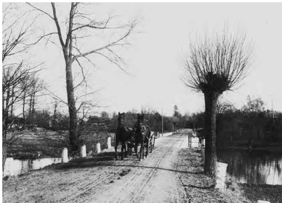
Trafikken var ringe, da Åsum Bro fotograferedes en dag omkring 1910. Foto: Åsum Sogns Lokalhistoriske Arkiv.
