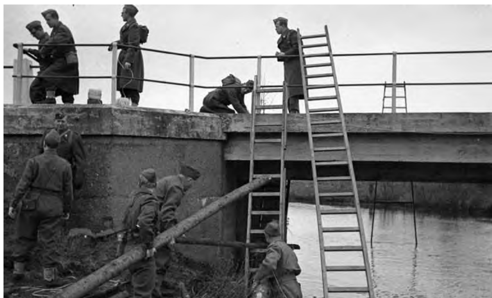
Den første bro af beton kender vi fra et billede fra 1953, hvor et kompagni hjemmевærnssoldater øver sig i at sprænge broen i stykker. Alle betydningsfulde broer i landet var planlagt at blive sprængt, hvis en fjendes fremrykning skulle sinkes. Foto: Fyens Stiftstidende/Odense Stadsarkiv.
