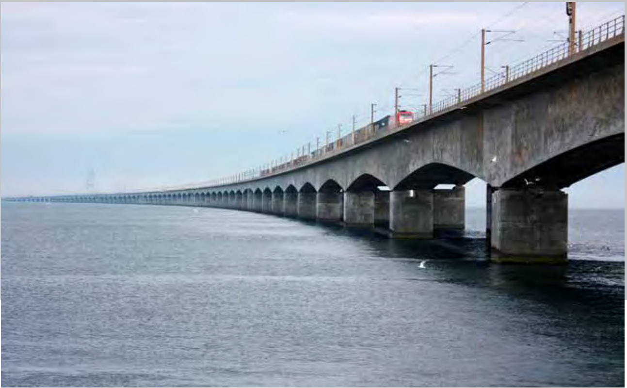
Den færdige 6,8 km lange Vestbroen på Storebælt består af i alt 324 elementer. Foto: COWI.
