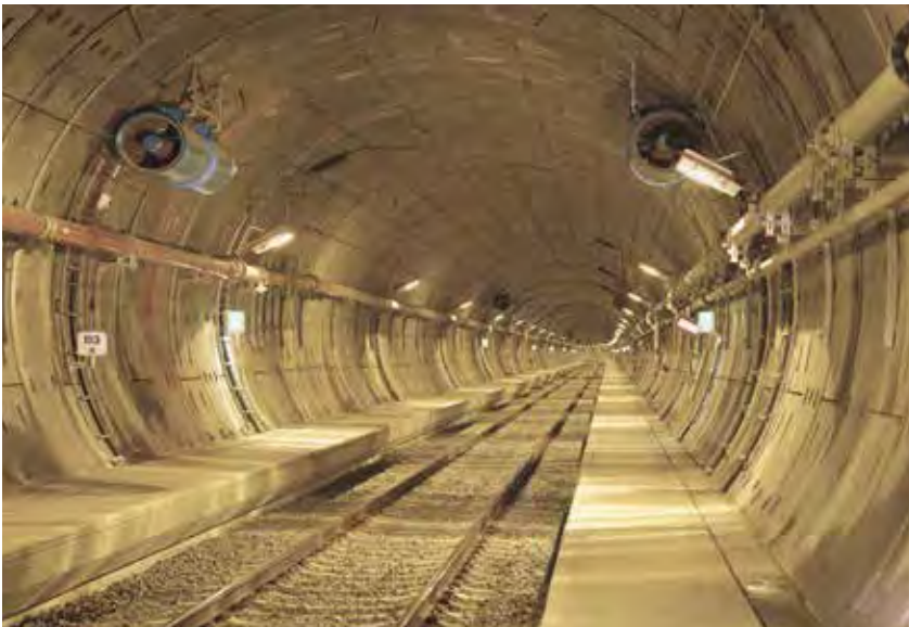
Den borede tunnel for banen under Østerrenden ved Storebælt er ca. 8 km lang og ca. 80 m dyb. Foto: COWI.
