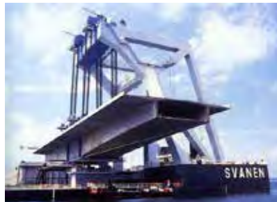
Montage af præfabrikeret broelement for Vestbroen i Storebælt på ca. 6.000 t med flydekranen "Svanen". Vestbroen er udformet som et unikt samlesæt af 324 elementer af pille-sænkekasser, søjler og brodragerer elementer fabrikeret på land og placeret på brostedet med den specialbyggede "Svanen" Foto: Sund & Bælt.
