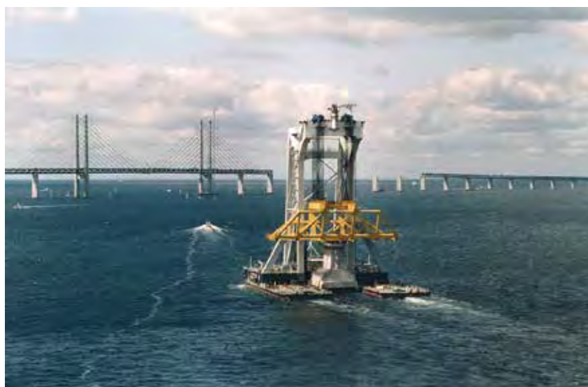
Øresundsbroens underdel bygget som præfabrikerede betonsænkemasser transporteret med den ombyggede "Svanen" flydekran som nu var på sin tredje anvendelse til brobygning. Foto: COWI.
