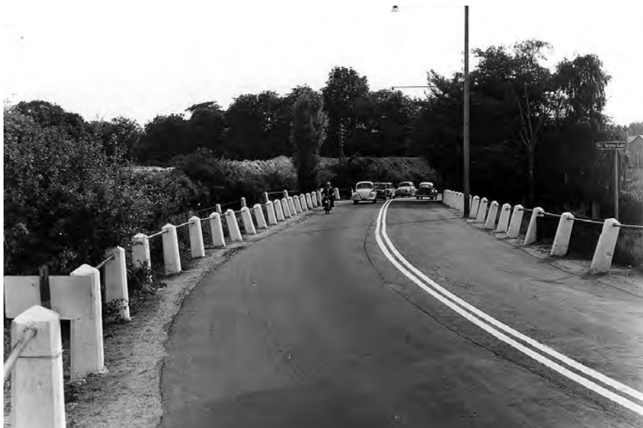
Figur 2. En mere moderne udgave af sikkerhedsrækværk havde erstattet kampesten med betonstøbte piller. De udgjorde dog stadig en stor fare ved påkørsel, som her ved overføring af jernbane i Sct. Jørgensgade i Odense i 1971 (Odense Stadsarkiv).
