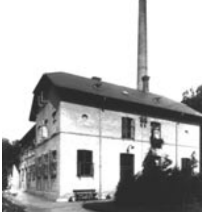
Spilddampen fra de to dampmaskiner i økonomibygningen på Vejle fjord Sanatorium blev som varmt vand ført til hovedbygningen, der lå et stykke væk, og brugt til at opvarme denne.
