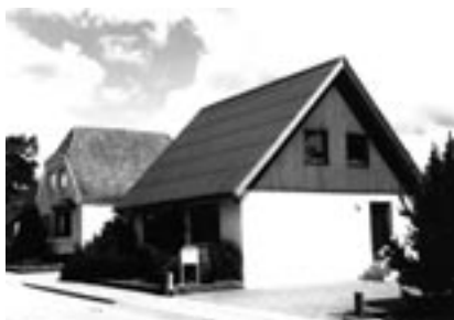
Bybilledet med skorstensløse gamle huse afslører, at her findes fjernvarme.
