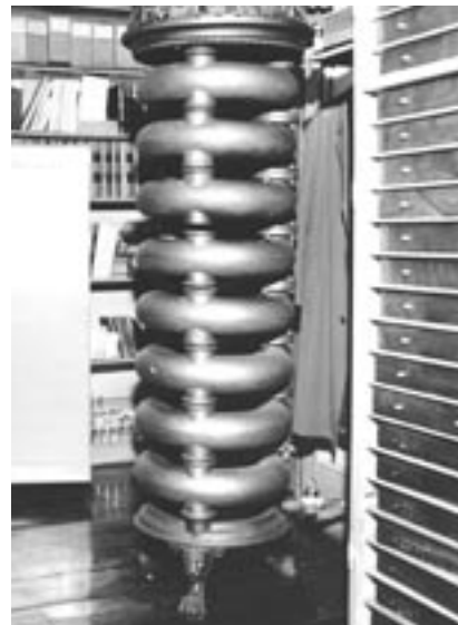
Dampradiatorerne på Zoologisk Museum fungerede i omkring 100 år. En af dem findes i dag på Danmarks Tekniske Museum. Radiatorerne kunne ikke finreguleres, hvorfor dampen blev ført gennem anlægget flere gange om dagen. Foto: H.V. Christensen, Zoologisk Museum, 1960
