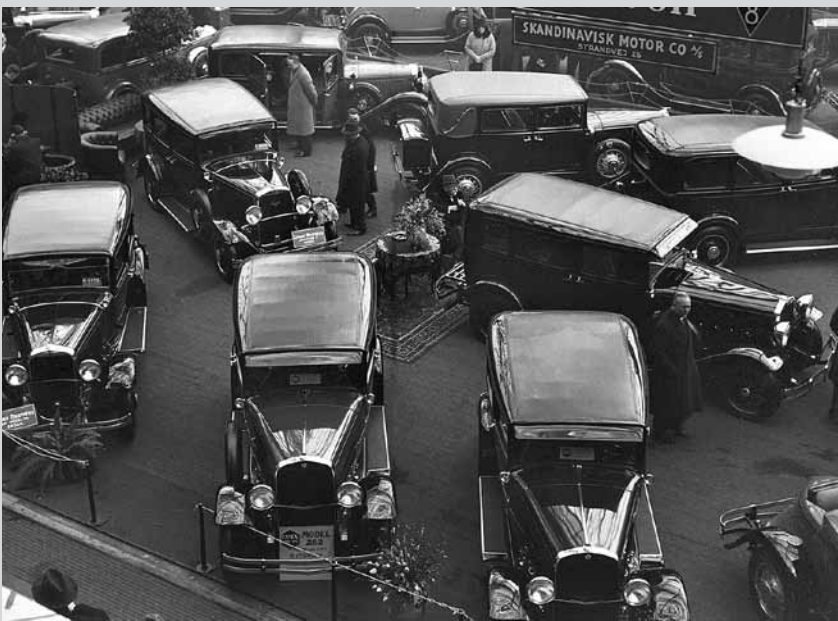
Fig. 12. Takket være det nye lavtryksdæk, kunne der i slutningen af 1920'erne konstrueres en helt ny generation af personbiler. Den bedre affjedring kunne klare større og kraftigere motorer og bære stærke karosserier, der var velegnede til kørsel om vinteren. Mens den lukkede sedan type kun udgjorde 43 % af amerikanske bilfabrikkers produktion i 1924, var billedet vendt i 1927, hvor 85 % af bilerne var lukkede, som de fleste på billedet fra en biludstilling i Forum omkring 1930.
