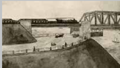
Indkørslen til den påtænkte hængefærge skulle ske gennem en bropille. Den 11 m. lange færge kunne klare to store vogne eller tre Ford T. Overfarten ville vare 5 minutter, og kapaciteten kunne udvides ved at koble en ekstra vogn på færgen. Samtidig tegning bl.a. bragt i Politiken 22. november 1923.
