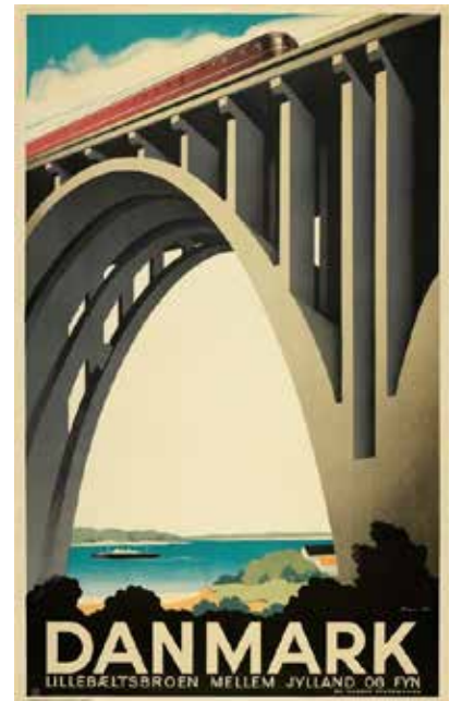
Fagene på land til Lillebæltsbroen blev bygget i jernbeton. Det gav derved et helt andet arkitektonisk udtryk end de middelalderborge, som var forbilleder for piller og indkørsler ved de første skitser til broen i 1880'erne. Plakat Sven Henriksen.
