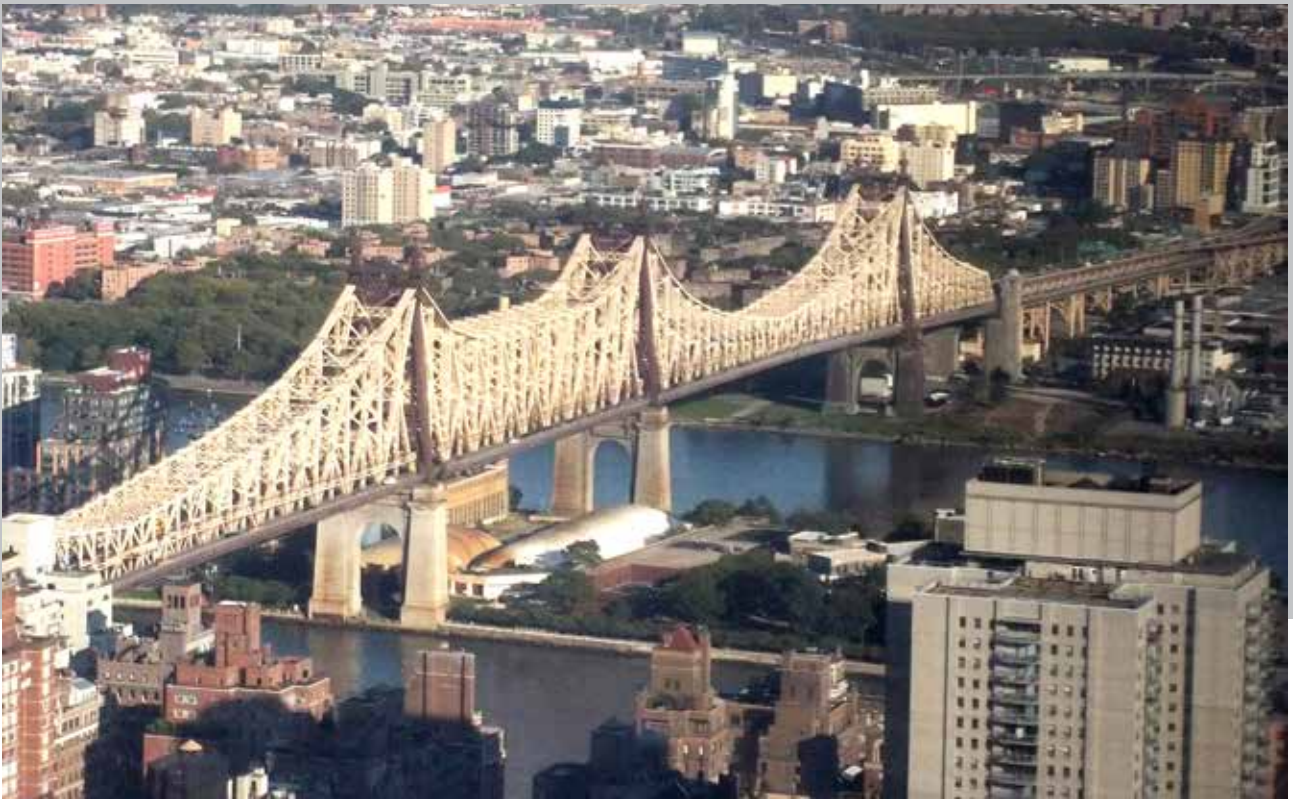
Queensboro Bridge. En række ikoniske broer var forbillede for Lillebæltsbroen. Den kombinerede jernbane- og vejbro over Blackwells Island bygget i en cantileverkonstruktion i New York fra 1909 er kendt af mange rejsende. I dag kaldes den også Queensboro Bridge, som blev yderligere kendt gennem musikken „59th Street Bridge“ af Simon & Garfunkel.
