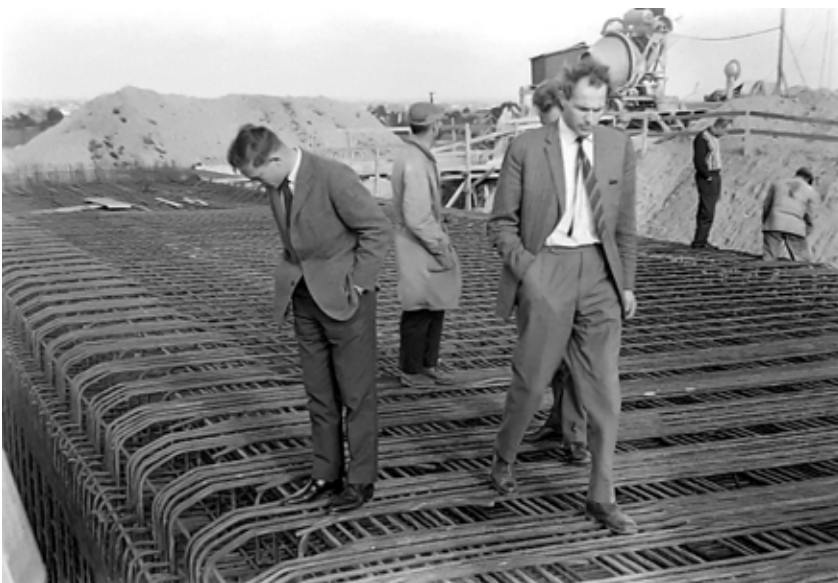
En vigtig del af al byggeri er kontrol med arbejdet. Her ses en inspektion af bro nr. 13 ved Skovsø ved Slagelse i 1961 i forbindelse med byggemøde.
