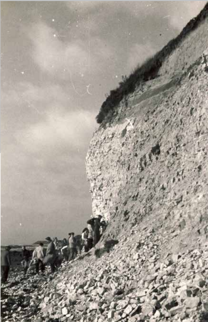
Harald K. Hansen var på 1. del af studiet til bygningsingeniør på Polyteknisk Lærestalt (det senere DTU) på ekskursion i 1950, for blandt andet at se geologi på Amager Klint, Bornholm.
